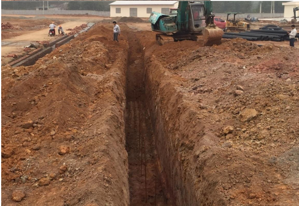
CHỐNG SÉT TRẠI GÀ CẨM KHÊ CỦA TẬP ĐOÀN HOÀ PHÁT
